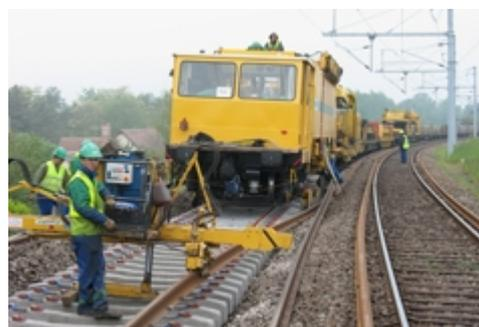
*Longs Rails soudés sur traverses béton*
